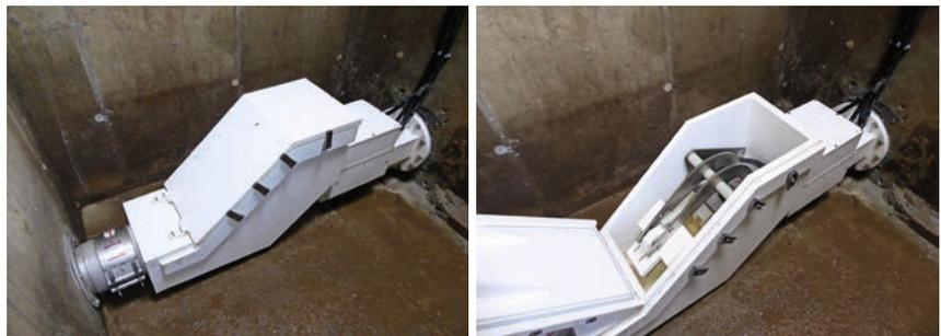
Fig. 8 Die teilgefüllte PNA beim RÜB Schindlau (ARA Ulrichsberg AT) mit integrierter Beruhigungs- und Messstrecke. Links: PNA mit geschlossenem Wartungsdeckel. Rechts: PNA im geöffneten Zustand. Die Fließrichtung ist von rechts nach links. Die Klappe (rechts sichtbar) drosselt die Weiterleitmenge, sodass der von INKA vorgeschriebene Soll-Wert zuverlässig weitergeleitet wird.
