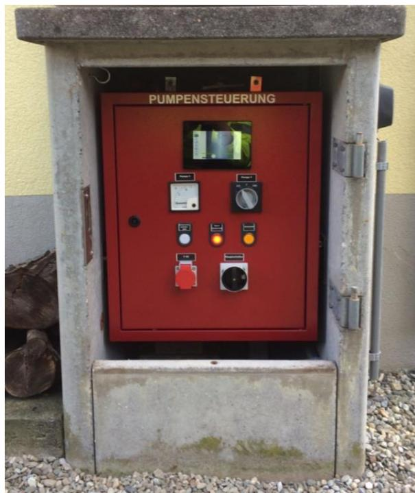
*Figure 6 : ALLinONE pour 1 pompe d'évacuation des eaux usées, en prenant l'exemple d'une station de pompage à Meiringen BE/CH; armoire LxHxP 500x600x250mm installée dans une cabine en béton existante*
