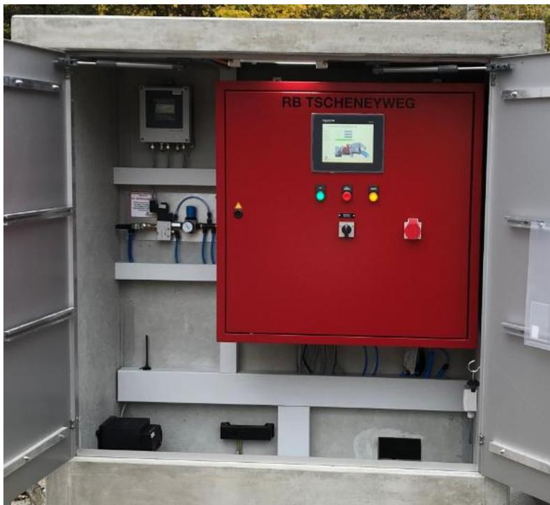
Figure 7 : Commande de bassin d'eau de pluie ALLinONE avec régulateur de débit pneumatique à Bienne BE/CH; armoire LxHxP 800x800x250mm.
