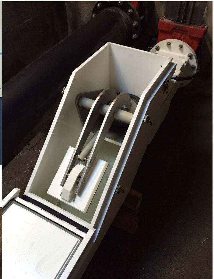
Le régulateur pneumatique d'écoulement (en haut avec accès d'entretien ouvert, en bas fermé) monté fin 2014.
