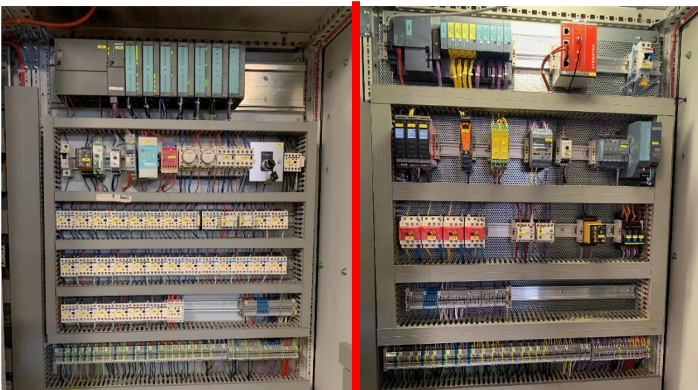
Abbildung 1: Links vor dem Retrofit / Rechts nach dem Retrofit.
