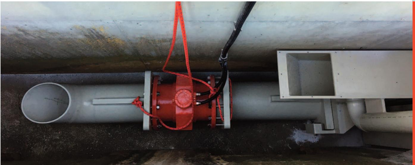
Montage de l'appareil DEM du système fixe de mesure du débit ainsi que du tuyau de refoulement dans l'un des deux puits.
