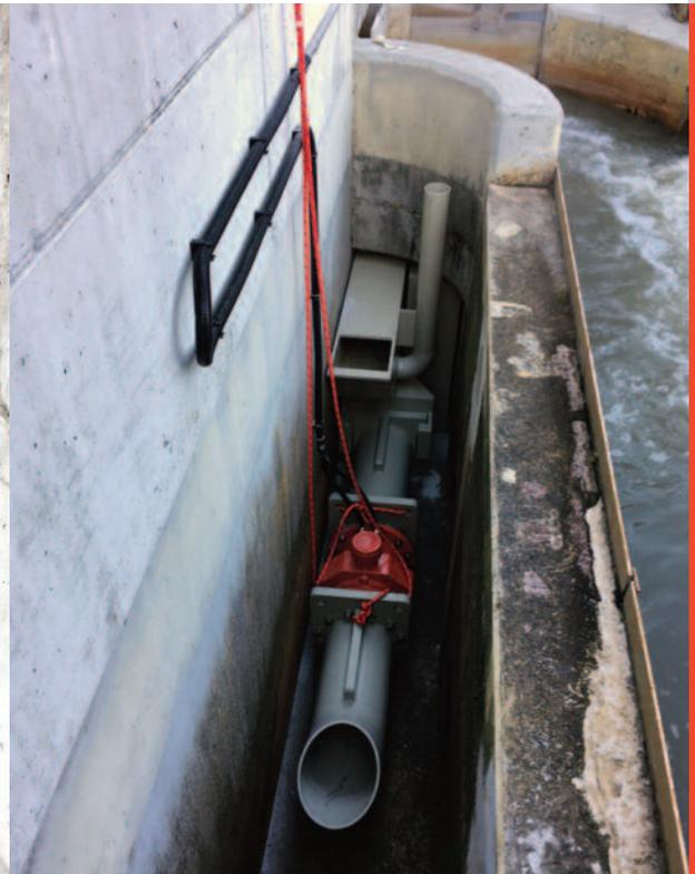
Canal de gauche pendant le montage de l'appareil DEM. En cas de niveau d'eau plus élevé, la décharge proprement dite se fait via le rebord qui passe du coin inférieur droit de l'image en biais vers le haut.
