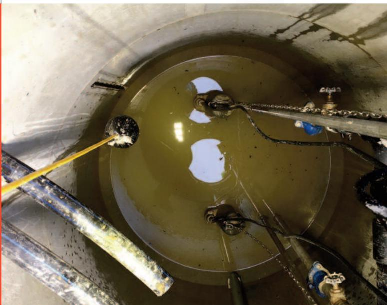
Le puits de la station de pompage principale qui est la seule à être pourvue de deux pompes fonctionnant en alternance.
