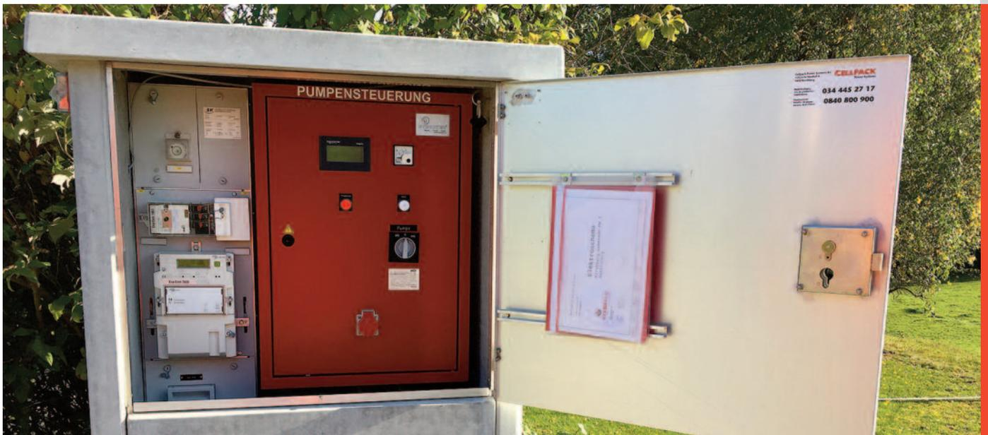
Vue dans l'une des nouvelles cabines avec commande compacte de pompes (à droite) et le compteur d'énergie (à gauche).
