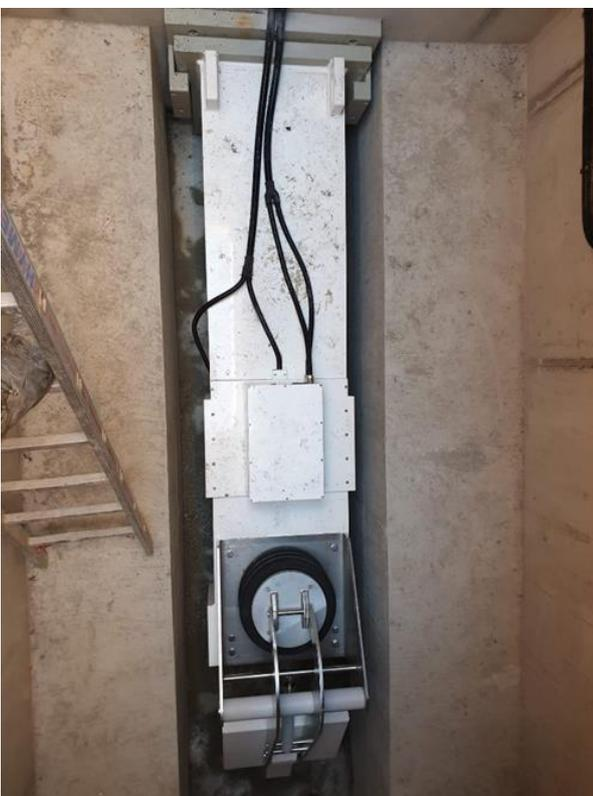
Figure 4: Le système de contrôle des flux utilisé dans le bâtiment. Par temps sec, l'actionneur pneumatique est au repos et le clapet reste ouvert jusqu'à ce que la mesure du débit détecte une augmentation de la décharge.
