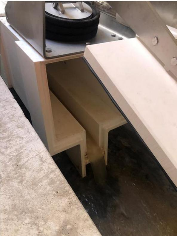
Figure 2: Zone de sortie de la TF-PNA. Par temps sec, le régulateur reste ouvert, tandis que les petites quantités de décharge dans la gouttière par temps sec sont mesurées avec précision.
