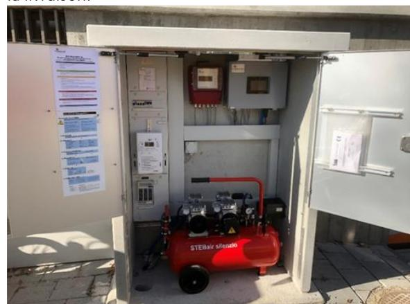
Figure 5: Le système a été acheté à STEBATEC et comprend la cabine, le traitement de l'air comprimé et la transmission des données à la station d'épuration des eaux usées.
