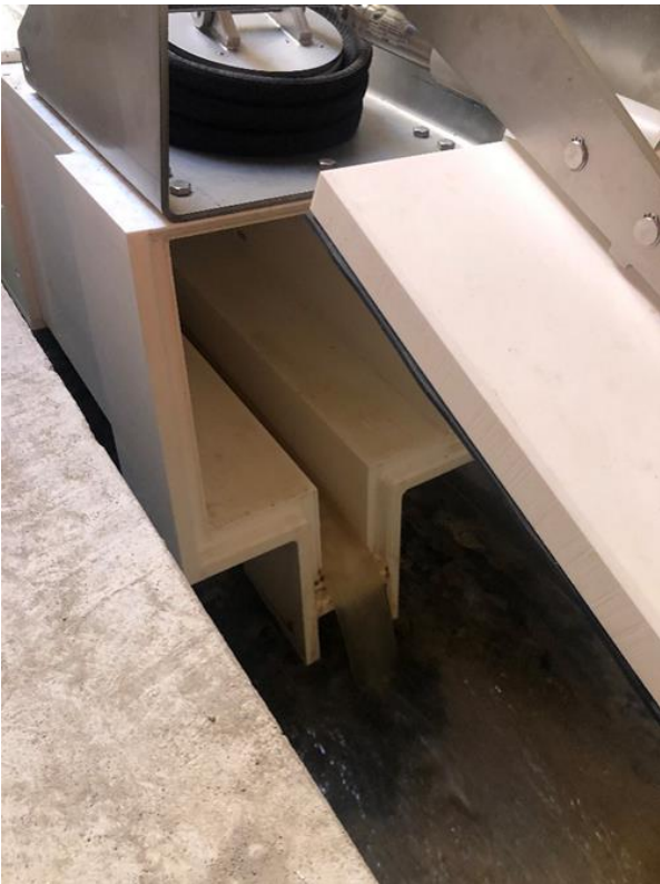
Abbildung 2: Auslaufbereich der TF-PNA. Während Trockenwetter bleibt die Drosselklappe geöffnet, während die kleinen Abflussmengen in der Trockenwetterrinne präzise gemessen werden.
