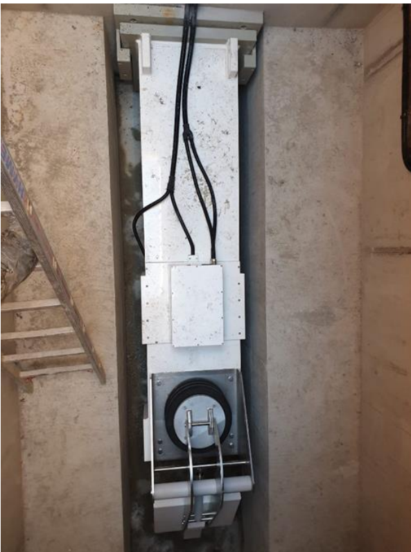
Abbildung 4: Das Abflussregelungssystem im Bauwerk eingesetzt. Der Pneumatikantrieb ist während Trockenwetter in Ruhestellung und die Klappe bleibt geöffnet, bis die Durchflussmessung erhöhten Abfluss feststellt.
