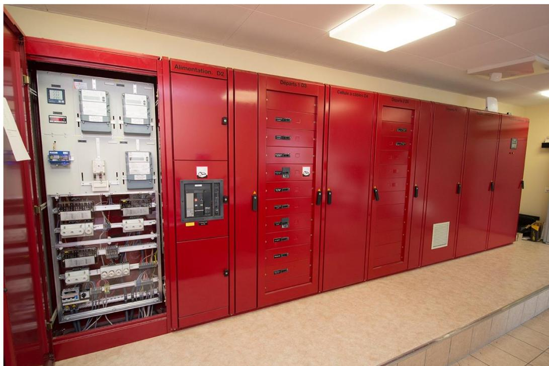
Les circuits électriques ont été partiellement rénovés et complétés par le mode d'urgence découplant le réseau public.
