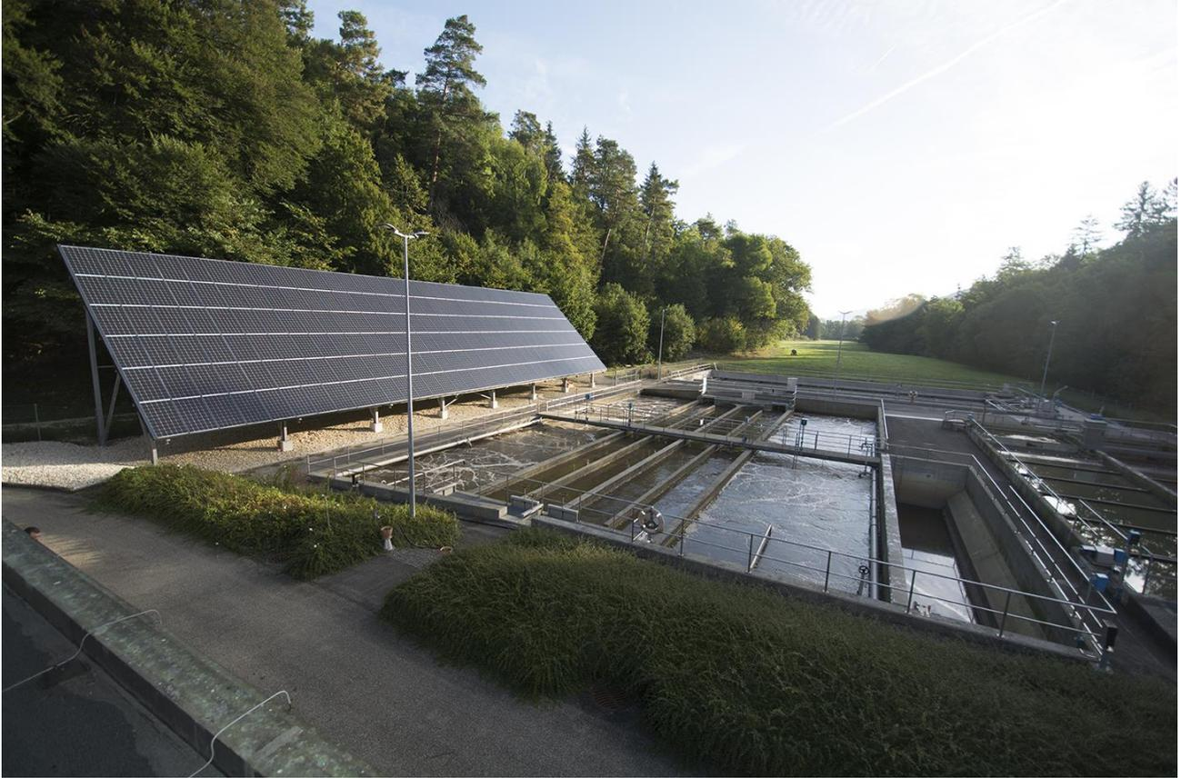
La nouvelle installation photovoltaïque est conçue pour couvrir au moins 10 % de la consommation d'électricité de la STEP, même par mauvais temps.
