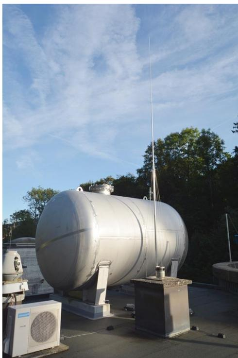
Le réservoir de gaz supplémentaire triple le volume de stockage et crée ainsi une plus grande flexibilité. L'antenne est utilisée pour la protection contre la foudre.
