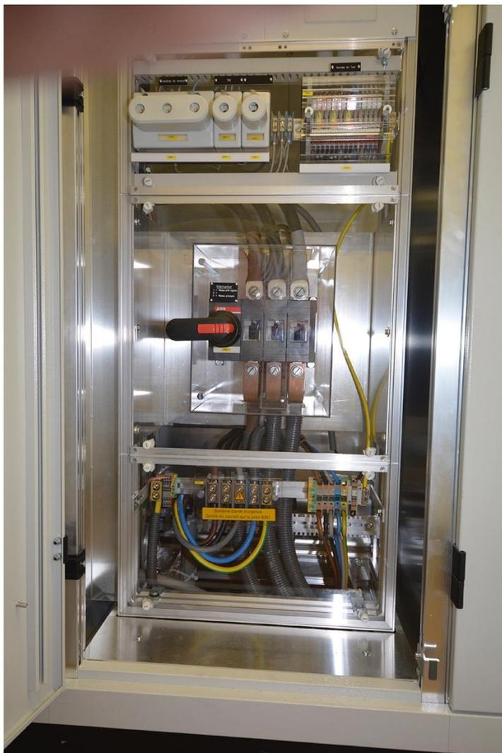
Avec la nouvelle distribution électrique, l'interrupteur principal peut être utilisé pour commuter du réseau électrique public au fonctionnement d'urgence.
