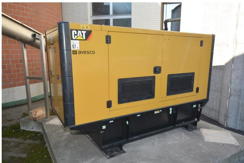
Le groupe électrogène de secours alimenté au diesel fournit un courant de 125 A, ce qui garantit plus d'un tiers de l'alimentation secteur en cas de panne de courant.
