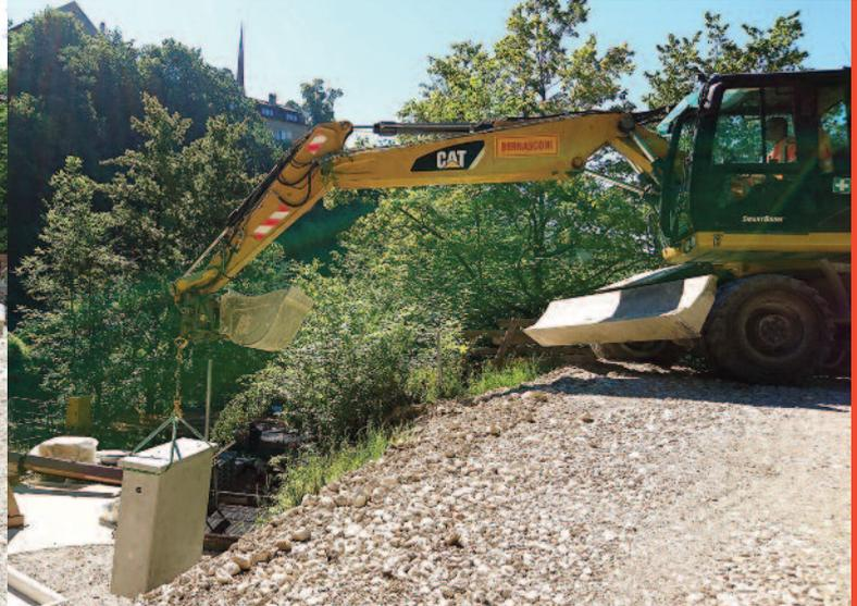
Eine der beiden Betonkabinen wird mit dem Bagger versetzt.
