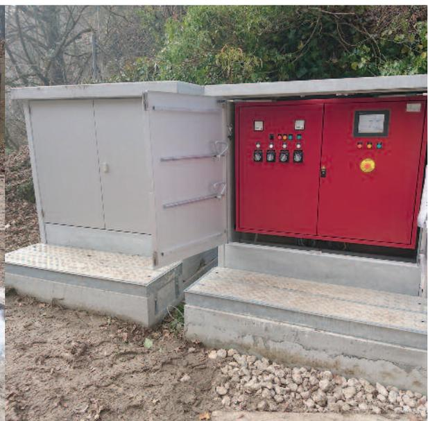
Hydraulikaggregat und Elektroschrank sind sicher in Betonkabinen untergebracht.
