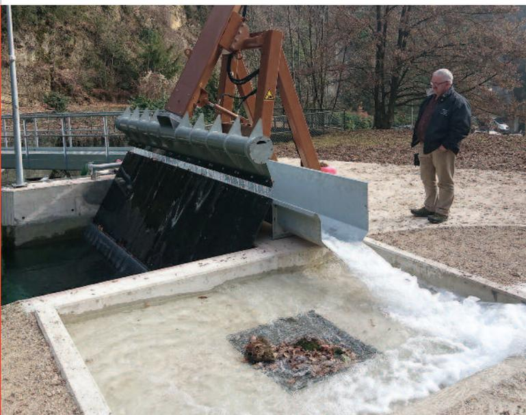
Das vom Reinigungskamm in die Rinne gehobene Treibgut wird in die Betonwanne mit Bodensieb gespült.
