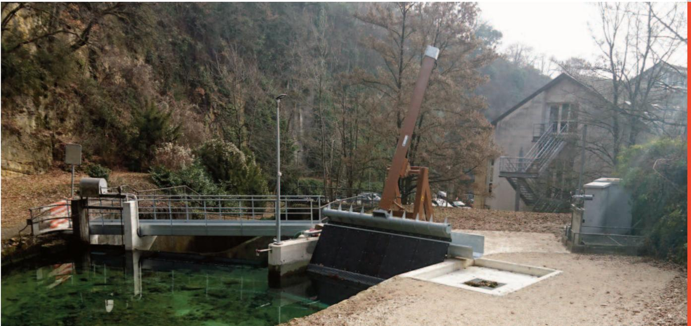
Die neue Anlage im Überblick (v.l.n.r.): Entlastungsschieber, Beleuchtung, Rechenreinigungsmaschine mit Rechenfeld, Spülrinne und Betonwanne, Hauptschieber und Betonkabinen für Hydraulikaggregat und Elektroschrank.
