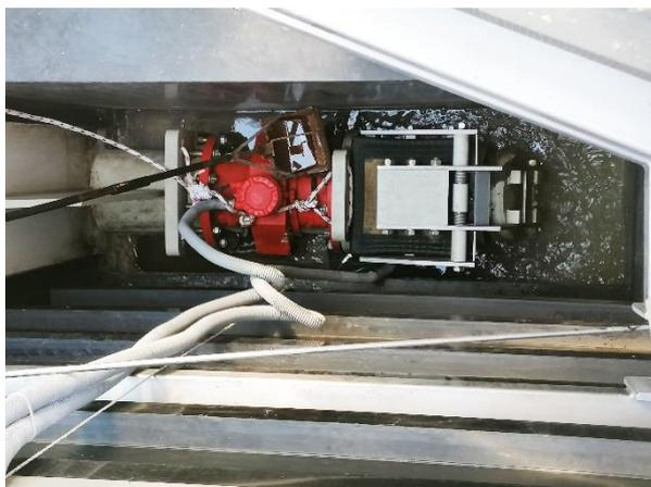
Abbildung 1-3 In die beengten Platzverhältnisse integrierter Drosselschacht mit PNA.
