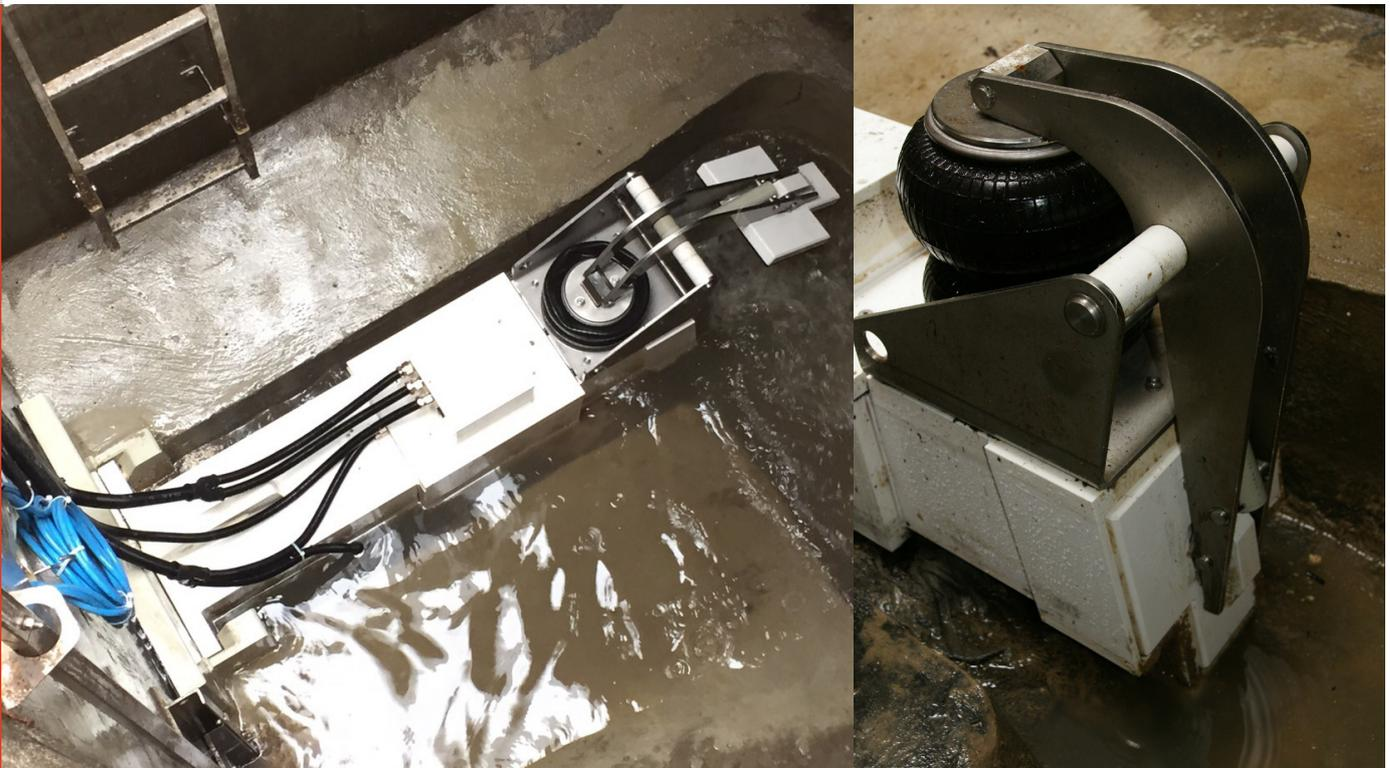
Bild 2 Abflussregler zur dynamischen Begrenzung der Weiterleitmengen.
