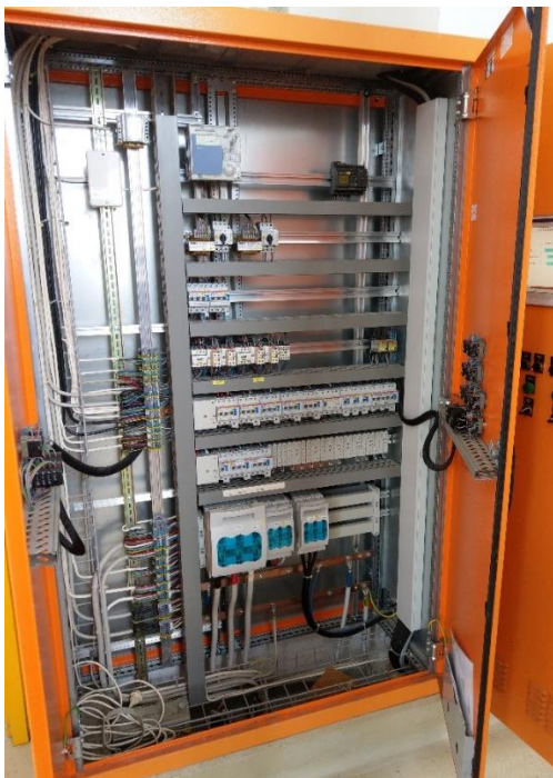
Abbildung 2 und 3: Der alte Steuerschrank wurde ersetzt. Stebatec war für die Planung, den Umbau, die Steuerung und die Inbetriebnahme zuständig – die entsprechenden Spezialisten der Stebatec waren daher am Umbautag Vorort.
