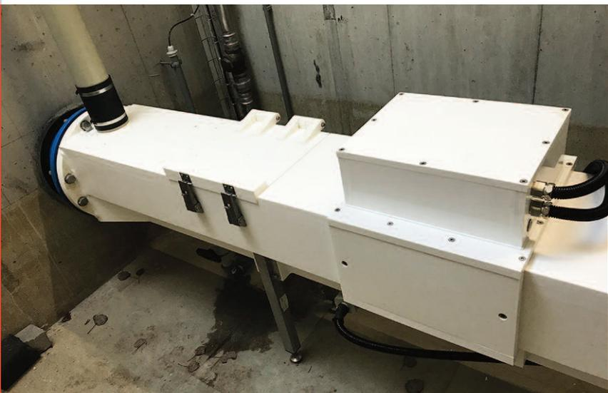
Die Fließgeschwindigkeit wird auf zehn verschiedenen Ebenen gemessen, um das gesamte Fließprofil verlässlich und genau abzubilden.
