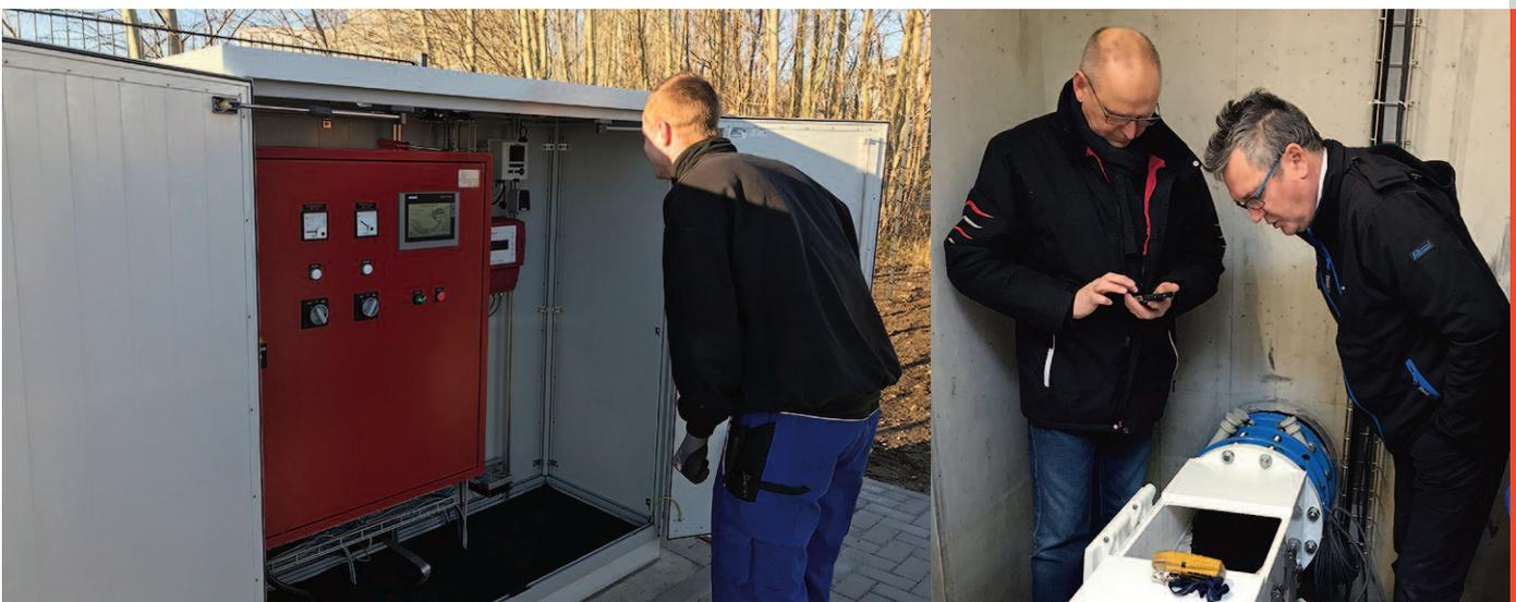
Der Schaltschrank der Messstrecke Nord mit DN 300. Rechts des Schaltschranks sind die beiden Messwertumformer zu erkennen.
