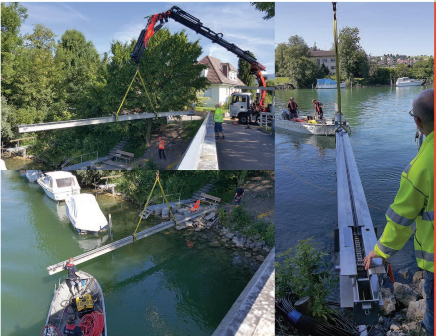
Montage einer der Schienen. Ein Autokran hebt sie in den Kanal zu den Monteuren am Ufer und auf dem Boot eines Spezialisten für Taucharbeiten hinunter.
