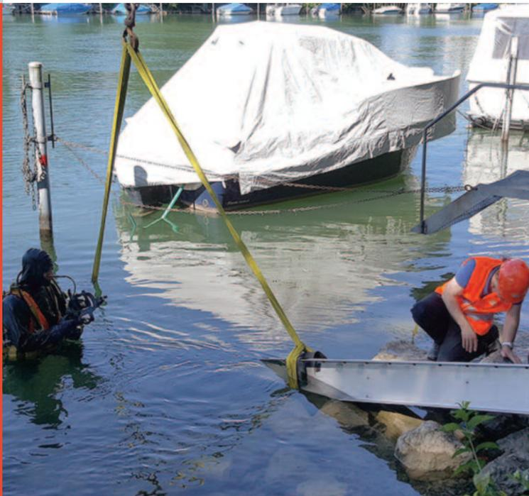
Fertig montierte Schiene. Ein Taucher hat für die Befestigung unter Wasser gesorgt.
