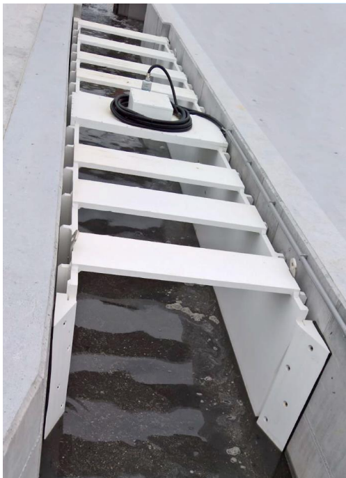
Einbau im Rechteckkanal mit minimalem Querschnittsverlust.
