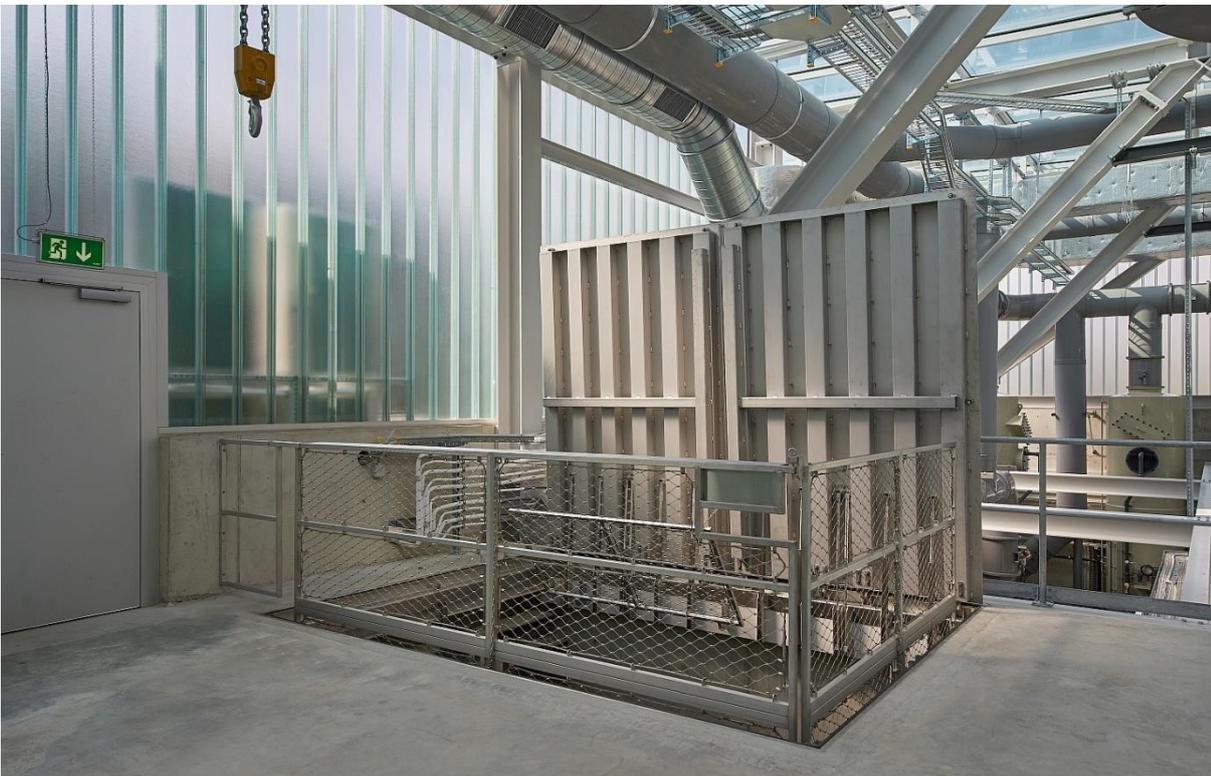
Abbildung 4: Bodentor komplett geöffnet / arretiert
