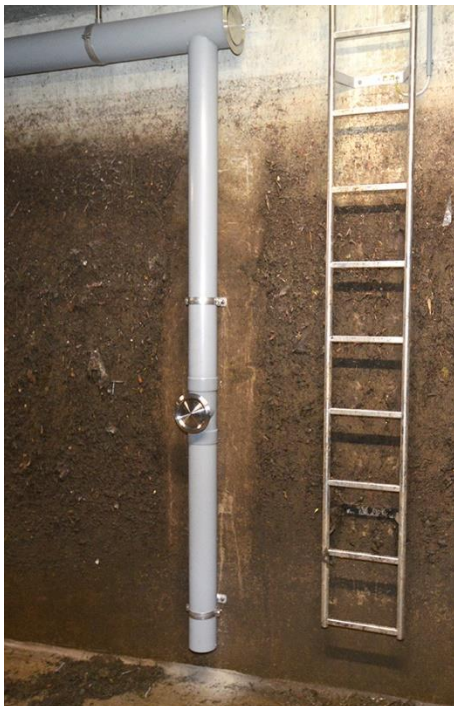
Abbildung 2: Absaugrohr
