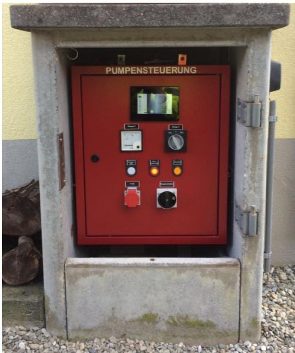
*Abbildung 6: ALLinONE für 1 Abwasserpumpe am Beispiel Pumpstation in Meiringen BE/CH; Schrank BxHxT 500x600x250mm nachgerüstet in einer vorhandenen Betonkabine.*
